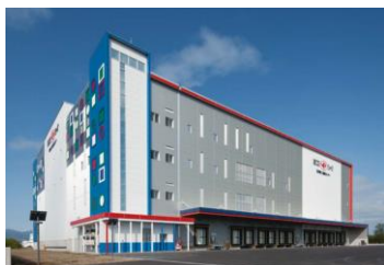
冷凍冷蔵倉庫
