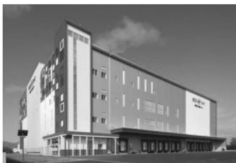
冷凍冷蔵倉庫
