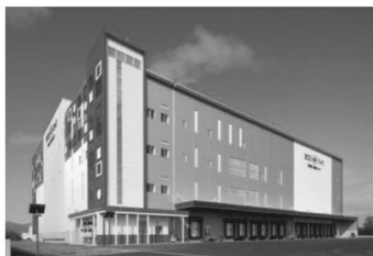
冷凍冷蔵倉庫
